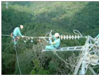
送電線保守作業
