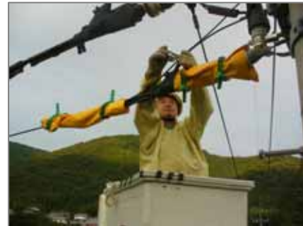
配電線保守作業
