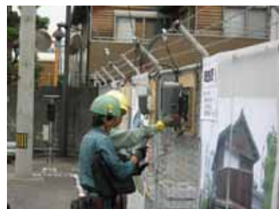
電気工事組合との合同災害復旧訓練
