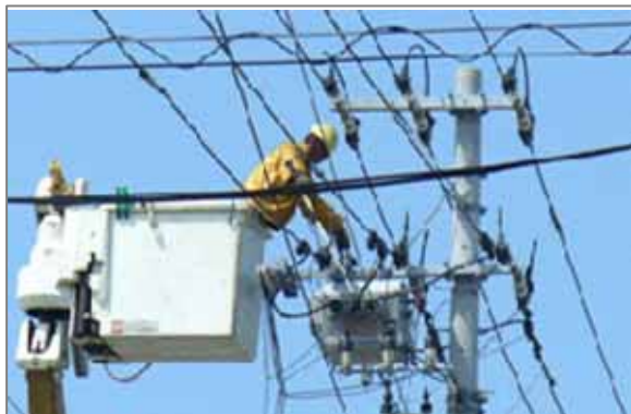
配電線の保守・管理
