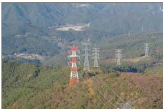
南阿波幹線(50万ボルト超高压送電線)
