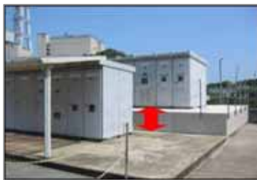
浸水被害防止のための変電設備の高(かさ)上げ
