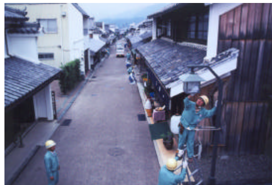
< 文化財の照明設備の点検・清掃 >
