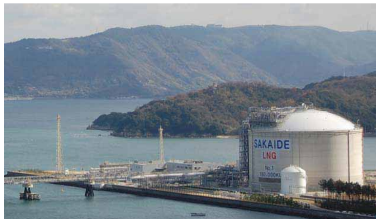
坂出LNG基地
