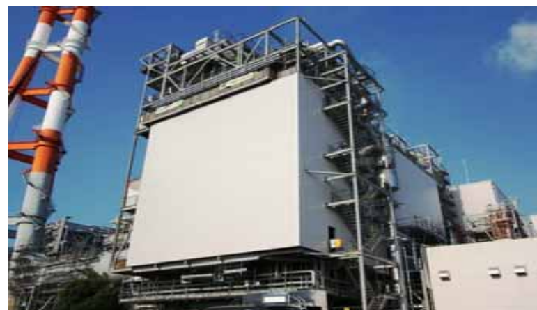
建設中の坂出發電所1号機
