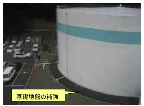
淡水タンク等水源の耐震性向上
