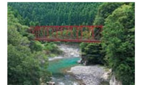
【明神口橋】大正元年に桧材で建造されたが、機関車の導入に伴い、鉄骨トラス橋に架け替え。橋長43.2m [地図]
