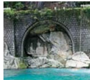
【釜ヶ谷棧道】石造アーチ橋。木造トラス橋として建造されたが、機関車の導入に伴い、昭和2年に単アーチ橋に架け替え。橋長12.3m [地図]
