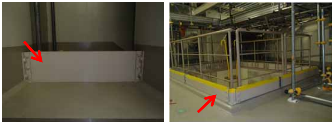
内部溢水により重要機器の水没を防ぐため、建物内の重要機器の部屋入口などに堰を設置
