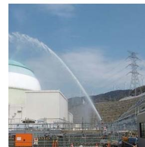
放射性物質の拡散抑制(原子炉格納容器への放水)
