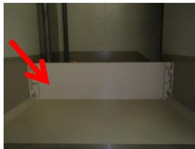
内部溢水による重要機器の水没を防ぐため、堰を設置
