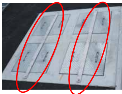
飛来物発生防止対策 (例：チッカープレートの固定)
