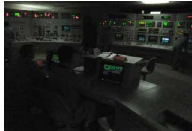
シミュレーター訓練（全交流電源喪失）
