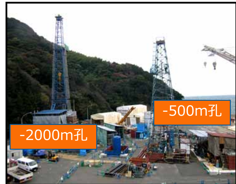
ボーリングの様子
