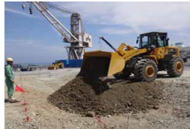
ホイールローダでの陥没箇所修復訓練
