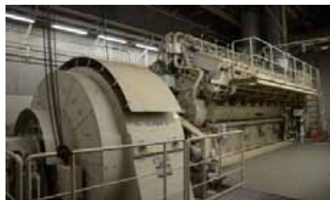
ディーゼル発電機（既設）
