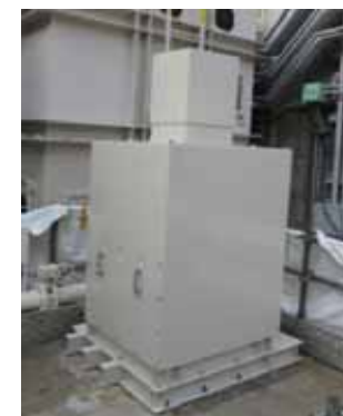
耐震型海水ピット水位計 (電波式)
