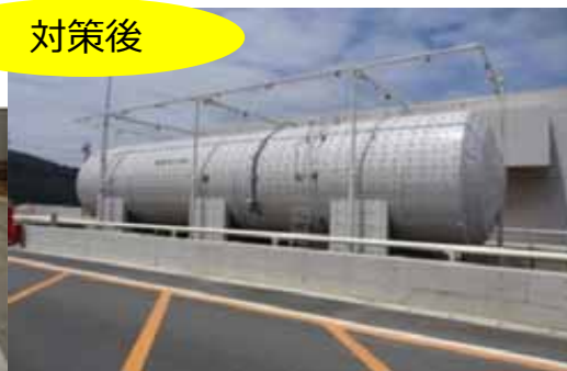
竜巻防護対策設備 (例：重油タンクの防護 (緩衝材))
