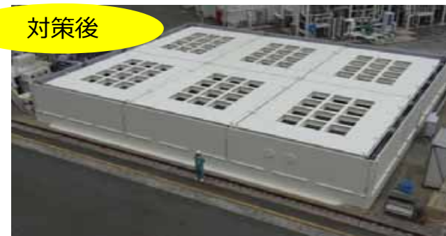
竜巻防護対策設備 (例：海水ピットポンプ室防護壁)
