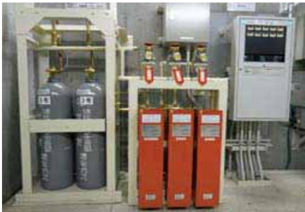
ハロン自動消火設備
