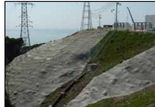
樹木の伐採後、モルタルを吹付
