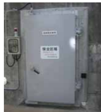
水密扉 (海水ピット)
