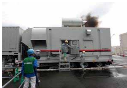
空冷式非常用発電装置
