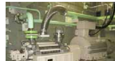
蒸気発生器代替注水ポンプ
