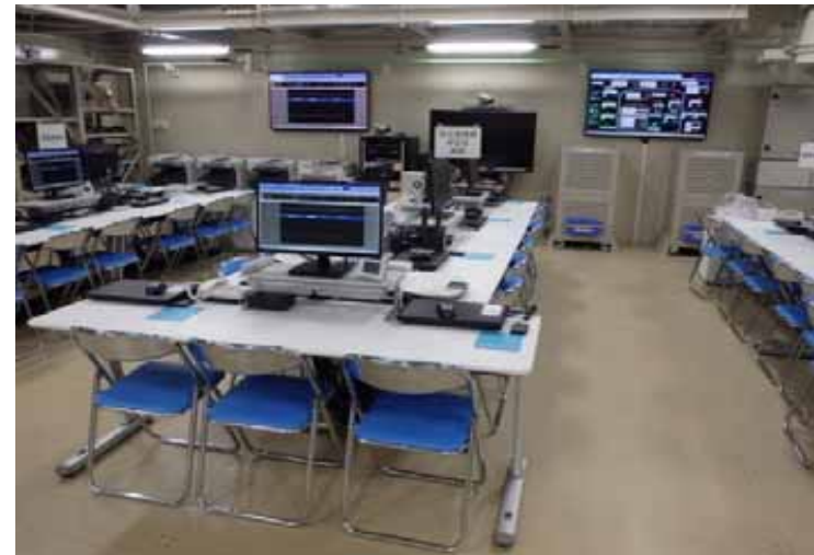
緊急時対策所の内部
