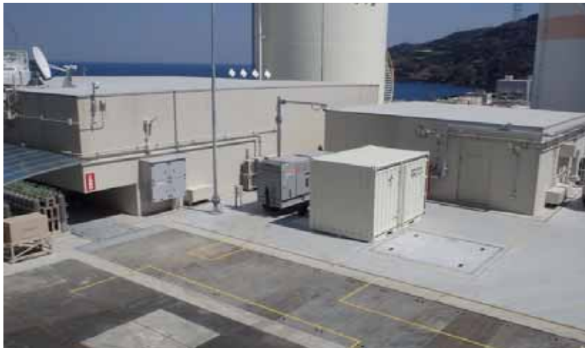
伊方発電所の緊急時対策所（左側の建物）
