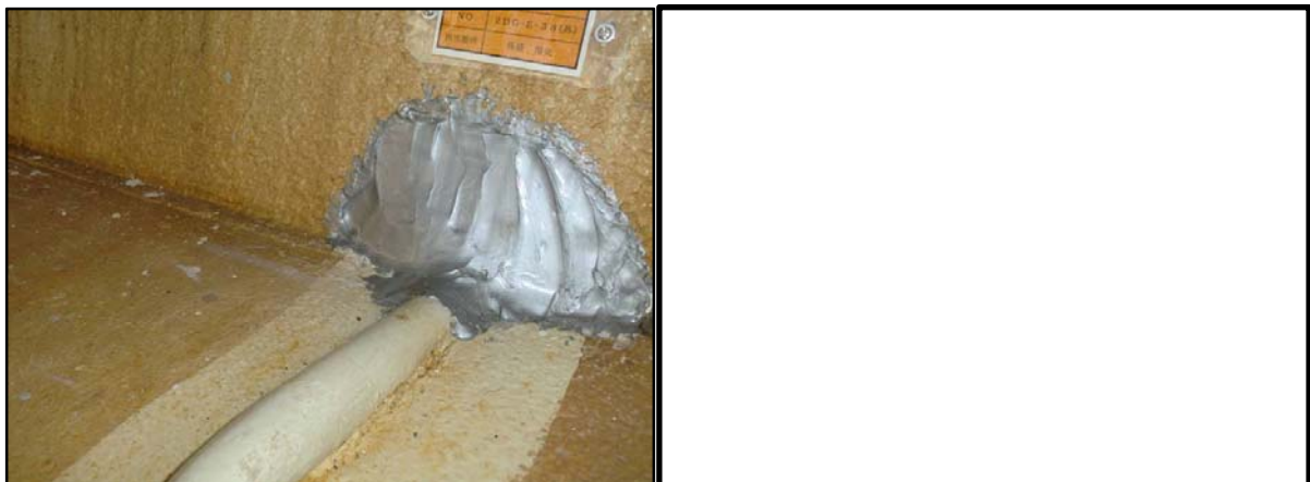
(電線管：貫通部番号 2DG-E-38)
