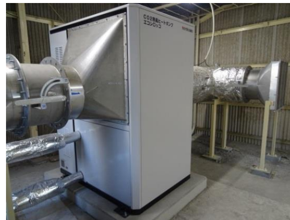
導入したヒートポンプ式熱風発生装置
