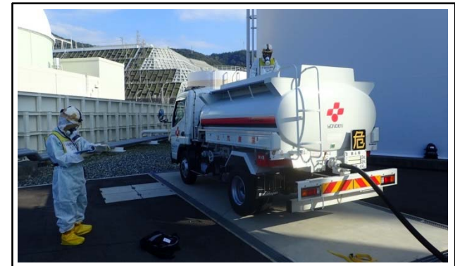
燃料補給作業
