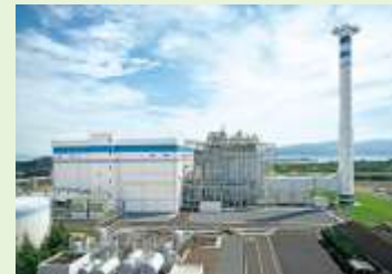
LNGコンバインドサイクル発電へのリブレース（坂出發電所2号機）
