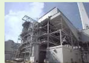
橋湾発電所の排煙脱硫装置
