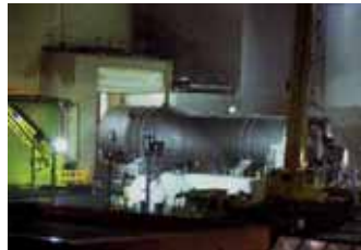
蒸気発生器取替
