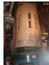
原子炉容器 上部ふた取替
