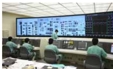
新中央制御盤
