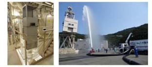
水素処理装置
