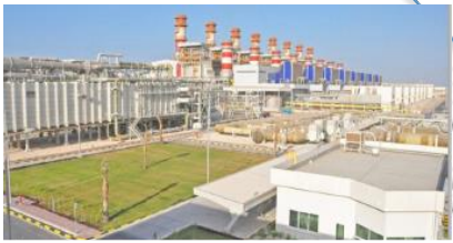
カタール発電・造水プラント
