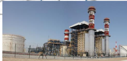
オマーン発電プラント
