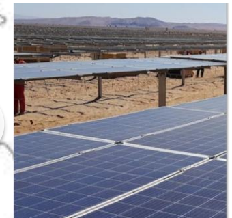
チリ太陽光発電プラント (建設中)
