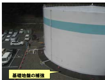
ろ過水タンクB地盤補強
