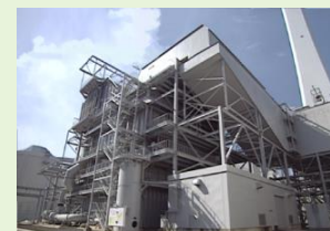
橋湾発電所の排煙脱硫装置
