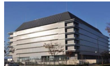
新高松データセンター 「Powerico (パワリコ)」
