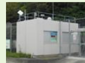
放射線を連続測定する モニタリングステーション
