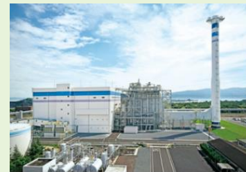
LNGコンバインドサイクル発電へのリブレース（坂出発電所2号機）
