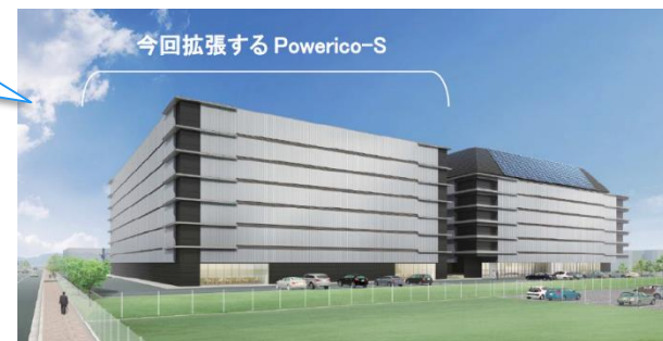
新高松データセンター「Powerico」
