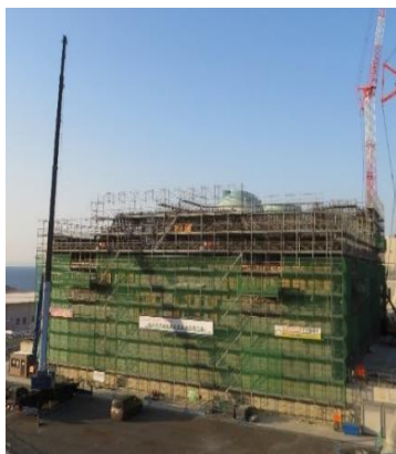
現地工事の様子
