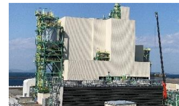
大洲バイオマス発電所 （愛媛県大洲市）
