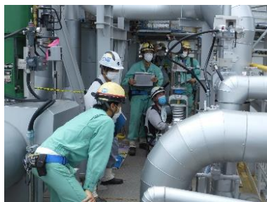
西条発電所 ボイラ試験
