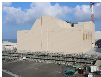
建設中の乾式貯蔵施設
