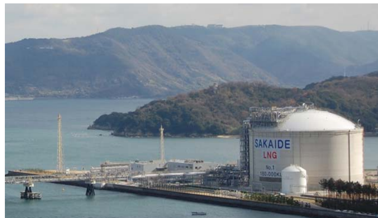
坂出LNG基地
