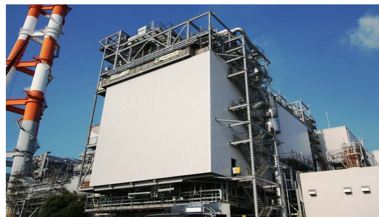
建設中の坂出發電所1号機
