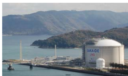
坂出LNG基地
