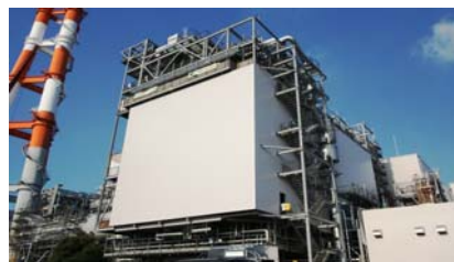
建設中の坂出発電所1号機
