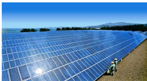
松山太陽光発電所（現状）
