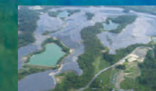
備前雲の上太陽光発電所 [出力：約7万kW]
