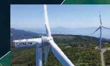
穎娃風力発電所 [出力: 約1.6万kW]
