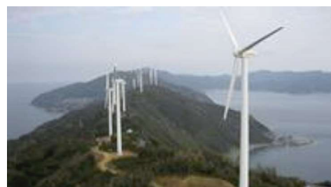
(再エネ発電所の建設)
