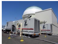
空冷式非常用発電装置
