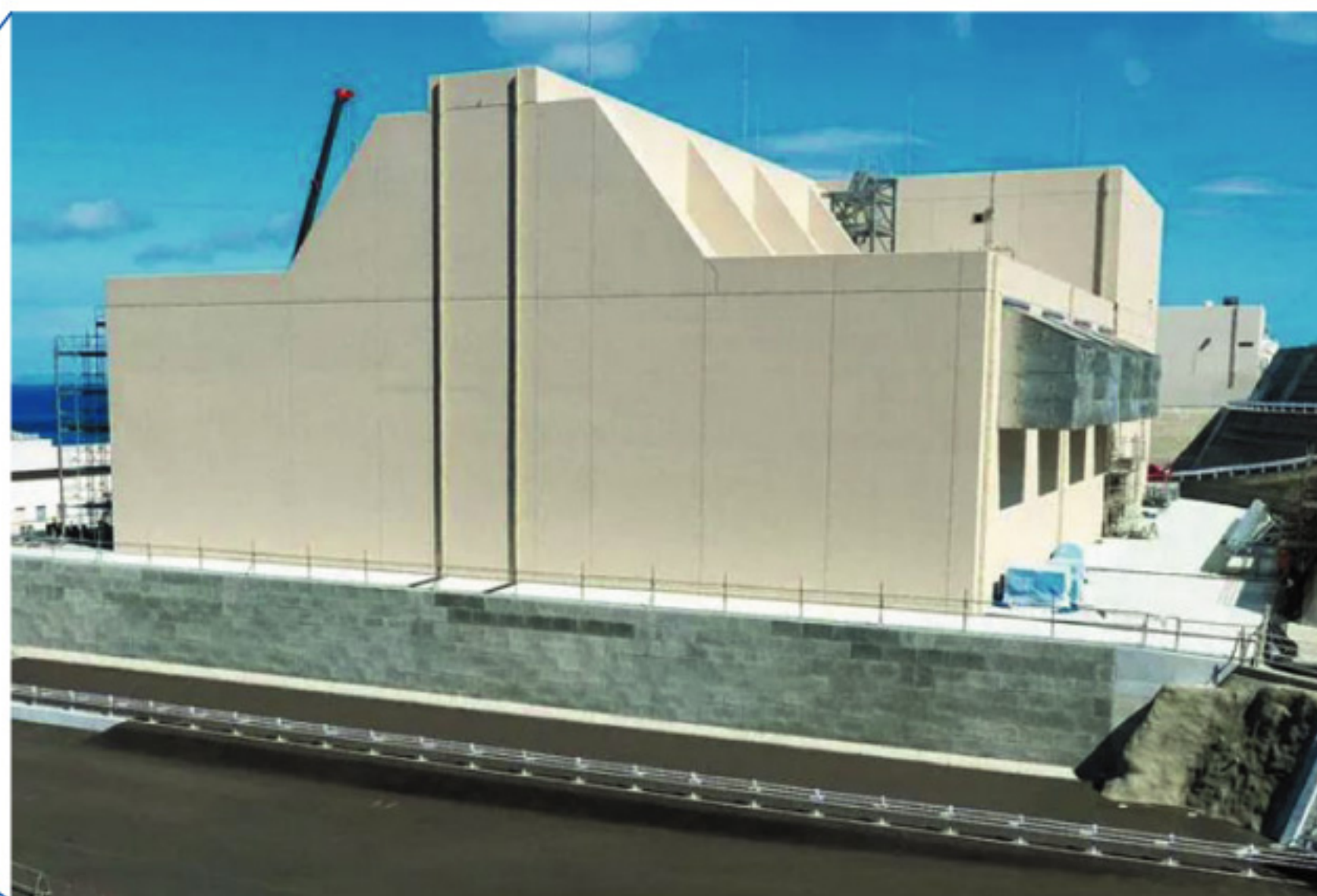
本年7月に運用を開始した乾式貯蔵施設外観
