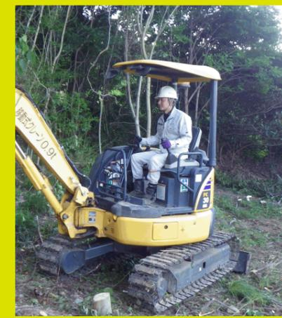
**岩佐** 私たちは鉄塔を支える土台の部分を作っています。木を伐採し、重機で整地して穴を掘り、鉄塔の柱となる部材を固定してコンクリートで固めるまでが仕事です。鉄塔はきっちり計算して建てられているので、土台もそれに合わせて正確な位置を出して合わせます。重機で力強く進める作業もありますが、大事な部分はかなり繊細。いいかげんな気持ちではできない仕事です。仕事を始めた頃は、重機を手足のように扱う先輩に憧れました。今では私もほとんどの重機を使えるようになりましたが、意外に小さな重機の扱
