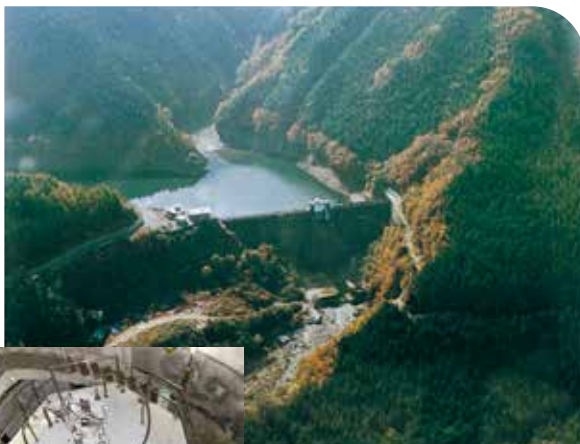
名頃ダム コンクリート重力式 堤 高 37.00m 堤 頂 長 119.40m 有効容量 1,150,000m 3 ダムカード
