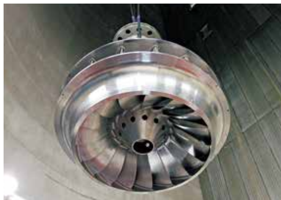
高効率水車への取替（柳谷発電所）
