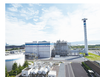
4基のうち3基の燃料をLNGに切り替えた坂出發電所
