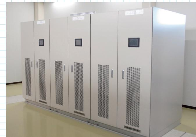
パワーコンディショナは、太陽電池パネルから出力される直流の電気を家庭で使える交流の電気に変換するインバータと、配電線の異常時（停電）などの場合に確実に電力系統から切り離す系統連系保護装置から構成されています。
