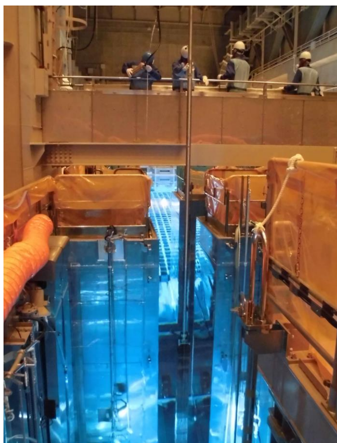
漏えい燃料特定調査 ( SHIPPING検査) 作業状況 (原子炉建屋内 3月20日撮影)
