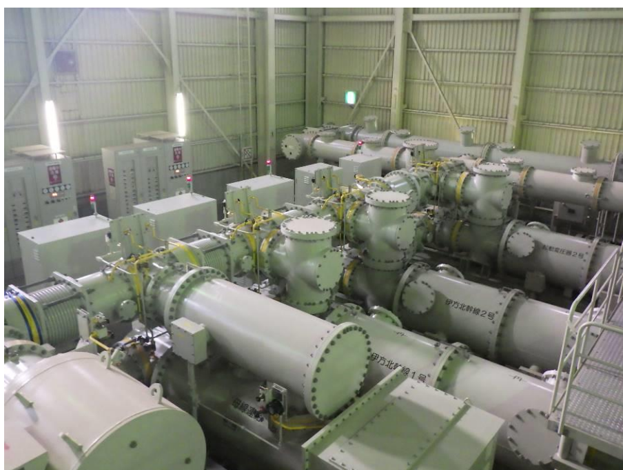
187kVガス絶縁開閉装置改造工事完了状況（屋内開閉所内 4月21日撮影）
