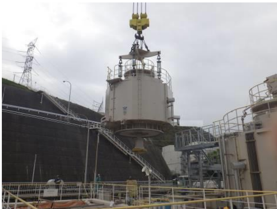
循環水ポンプ点検（ポンプモータ吊り込み）作業状況（屋外 4月14日撮影）
