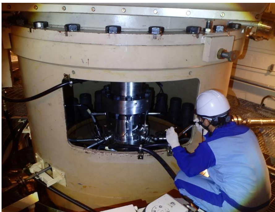
1次冷却材ポンプ試運転状況（原子炉格納容器内 5月15日撮影）
