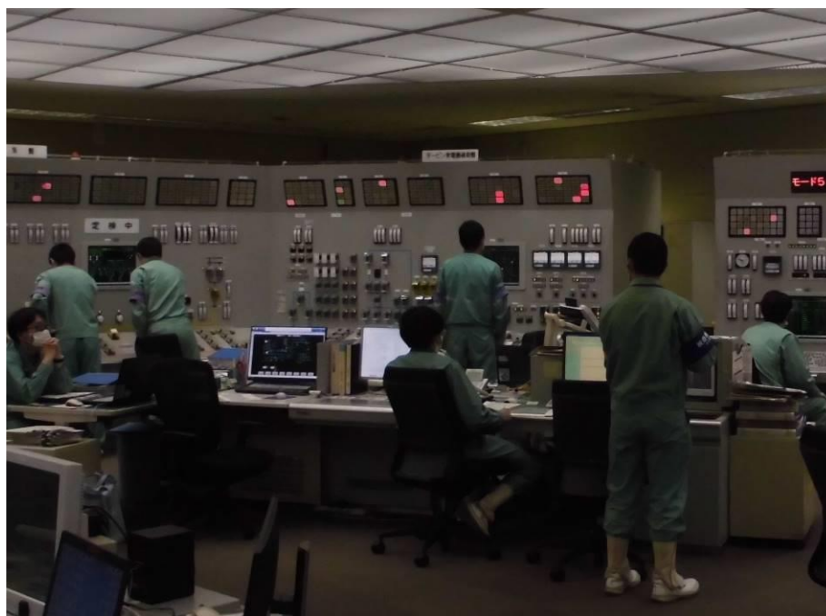
非常用予備発電装置機能検査 ※1 状況（中央制御室内 ※2 5月16日撮影）
