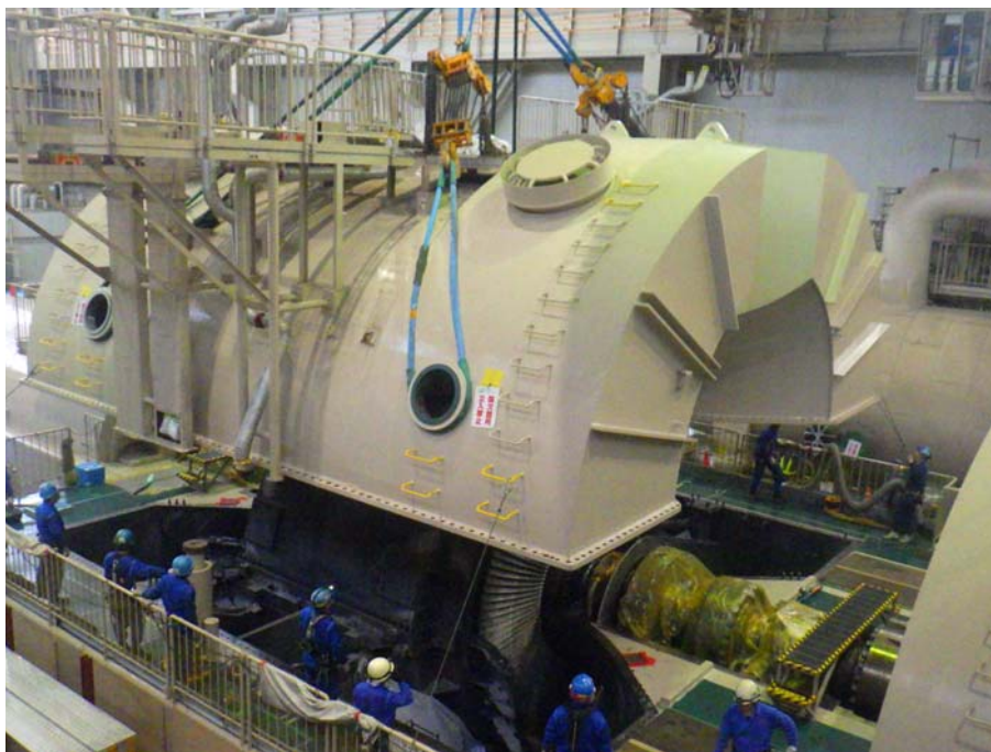
タービン点検（車室吊上）作業状況（タービン建屋内 7月23日撮影）
