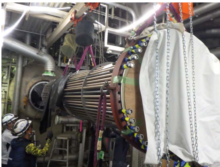
スチームコンバータ※加熱管の取替作業状況（タービン建屋内 7月18日撮影）
