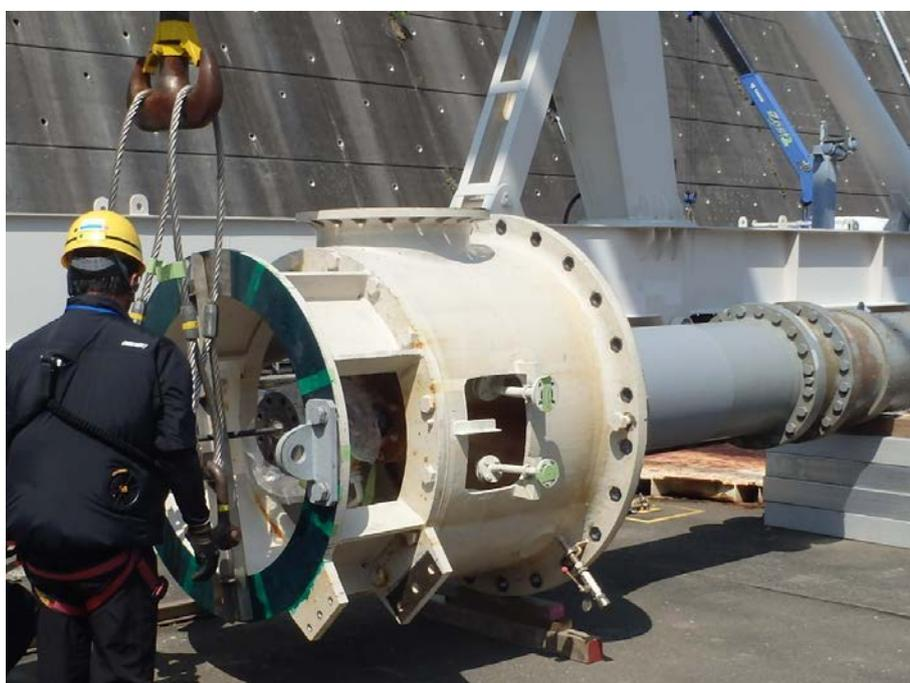
海水ポンプ※点検（ポンプ吊出）作業状況（屋外 8月4日撮影）
