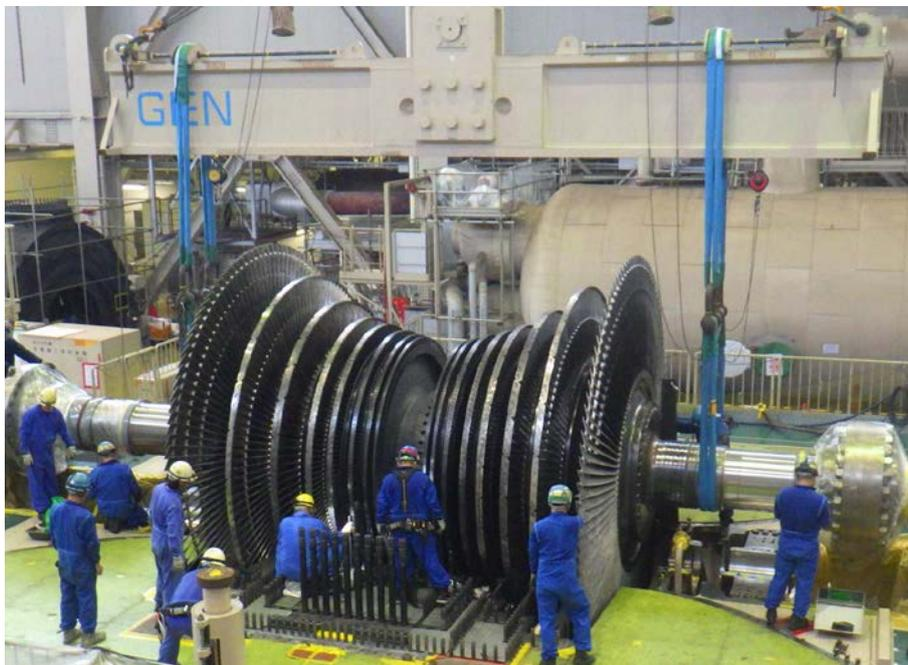
タービン点検（ロータ吊込み）作業状況（タービン建屋内 8月15日撮影）
