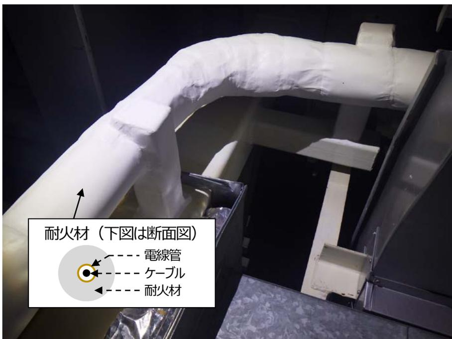
火災防護対策工事（電線管への耐火材施工）実施状況（原子炉建屋内 8月6日撮影）
