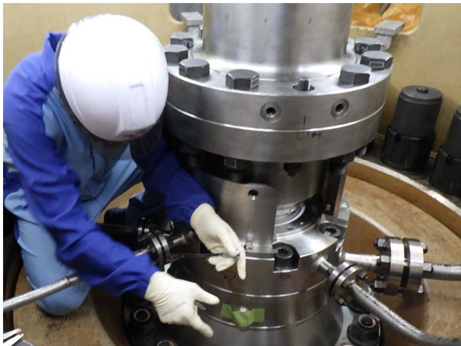
1次冷却材ポンプ点検（付属配管復旧）作業状況（原子炉格納容器内 9月2日撮影）
