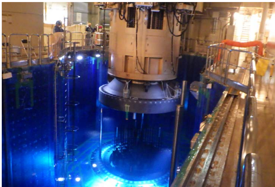
原子炉容器開放（上蓋吊上）作業状況（原子炉格納容器内 10月19日撮影）
