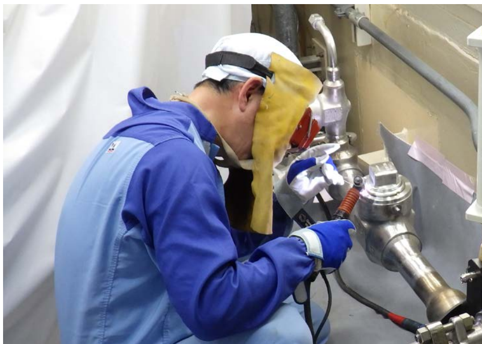
1次系弁取替工事（溶接）作業状況（原子炉格納容器内 11月10日撮影）
