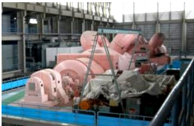
撤去前のタービン発電機
