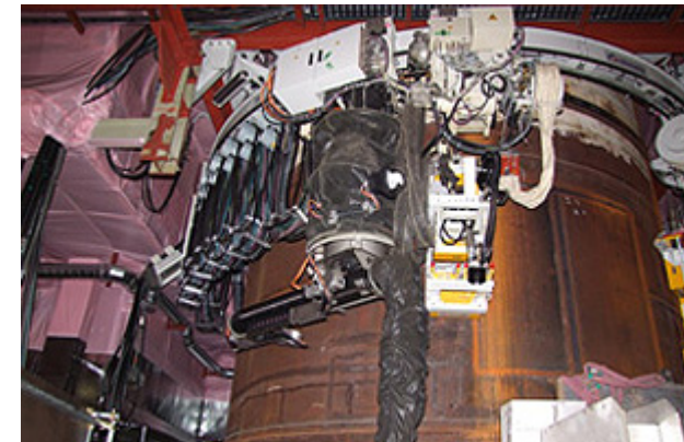
遠隔解体装置（熱交換器本体を 遠隔で分割切断する装置）
