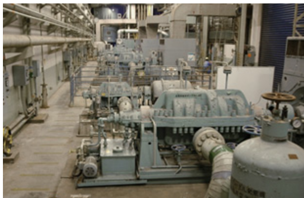
撤去作業着手前
