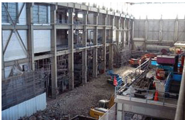
タービン建屋内構造物の撤去の様子2
