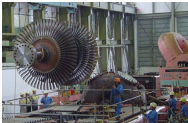
タービン発電機撤去作業中の様子
