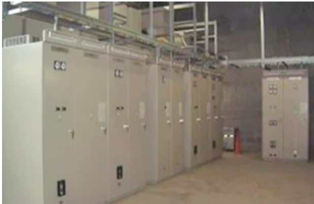
新電気盤設置
