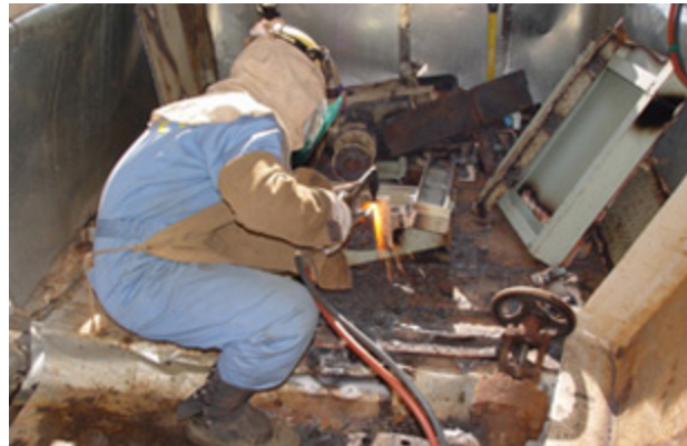
解体物小割作業の様子
