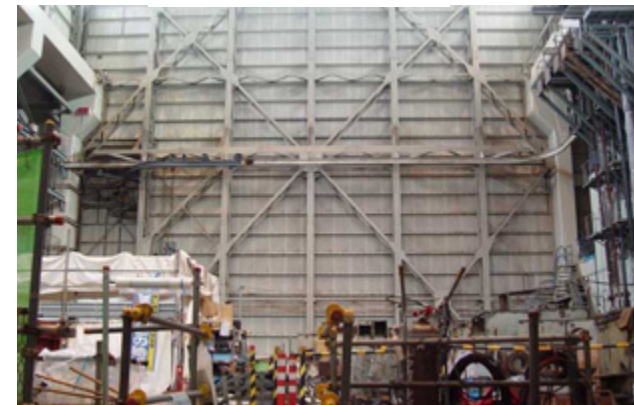
撤去物の吊り出し
