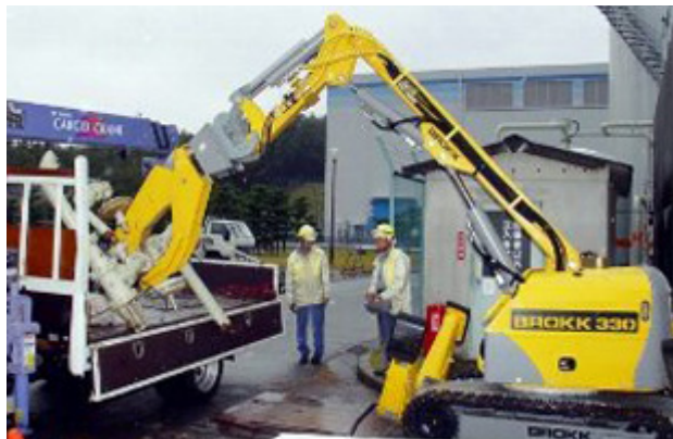
小型遠隔重機による機器の撤去
