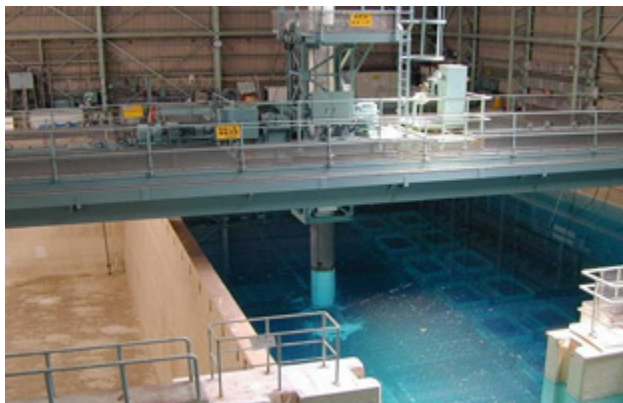
使用済燃料冷却池の工事前の状況
