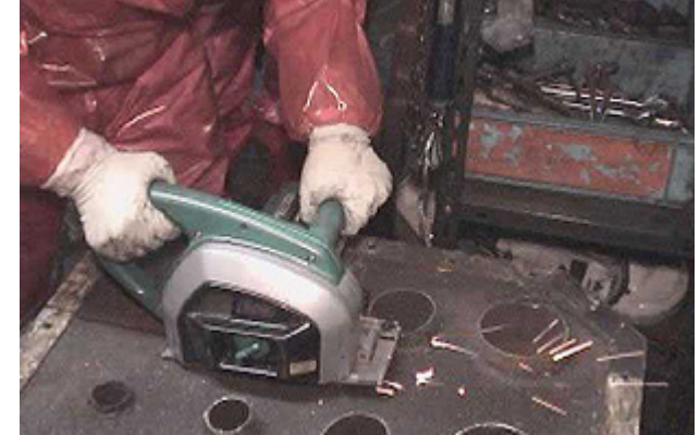
燃料分離設備フィルタ小割作業
