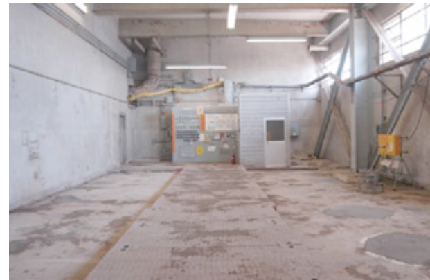
撤去作業後の様子
