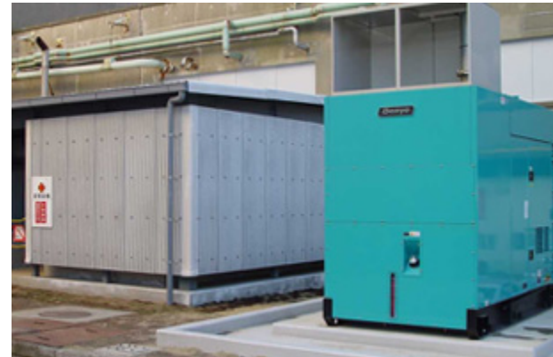
変圧器・汎用ディーゼル発電機設置
