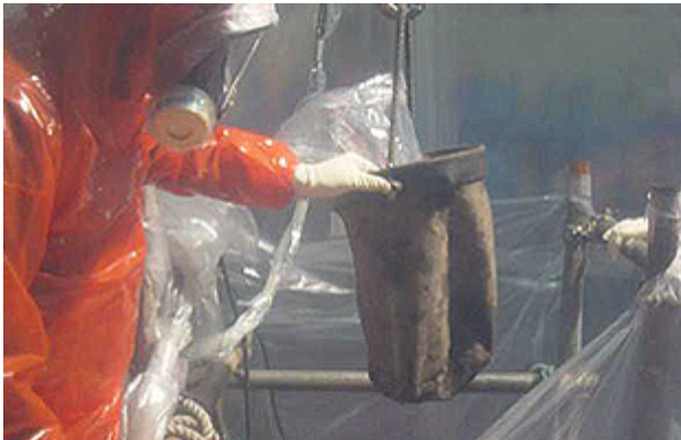
撤去物の吊り出し
