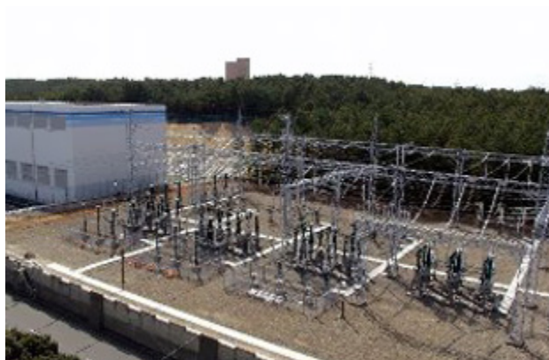
撤去前の様子
