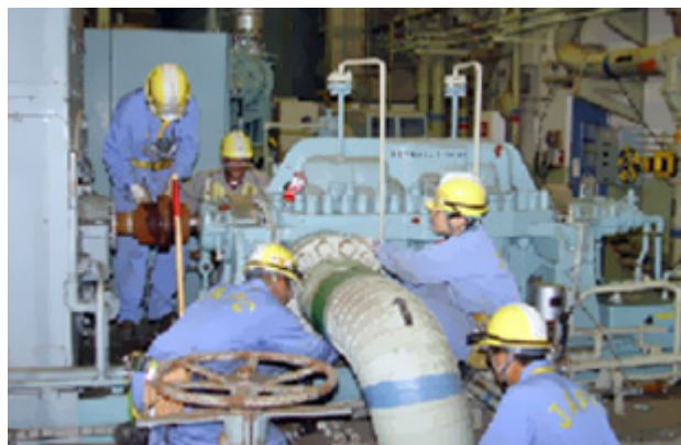
給水ポンプ撤去作業
