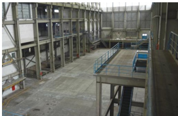
タービン建屋内構造物の撤去後
