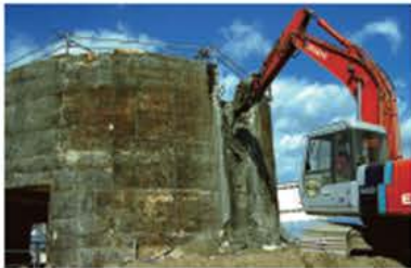
原子炉格納容器の解体
