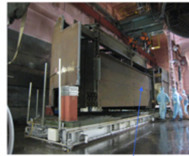
分割体を2次切断エリアへ定置
