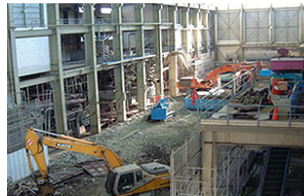
タービン建屋内構造物の撤去の様子1
