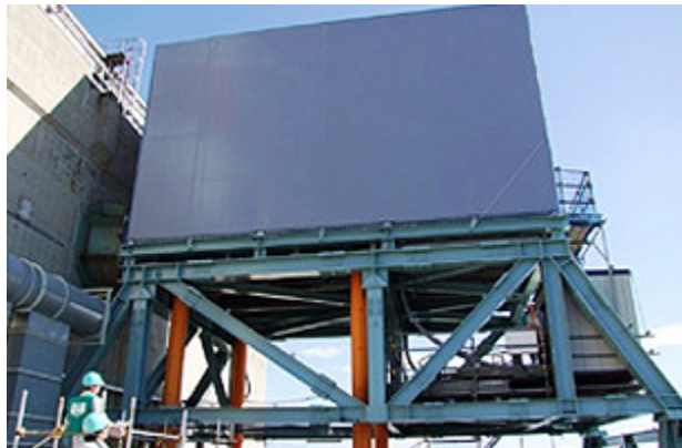
ジャッキ設備（熱交換器本体を 吊り上げるジャッキ装置）
