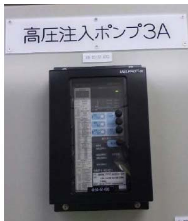
デジタル化後の保護継電器（高圧注入ポンプ 3 A の例）
