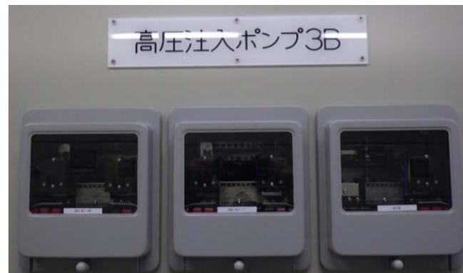
デジタル化前の保護継電器（高圧注入ポンプ3Bの例）
