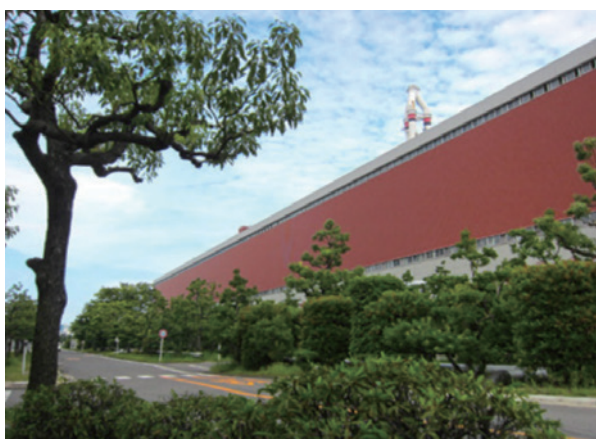
坂出发電所構内の緑化設備
