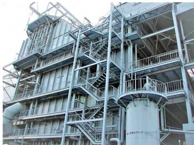
排煙脱硫装置(橘湾発電所)
