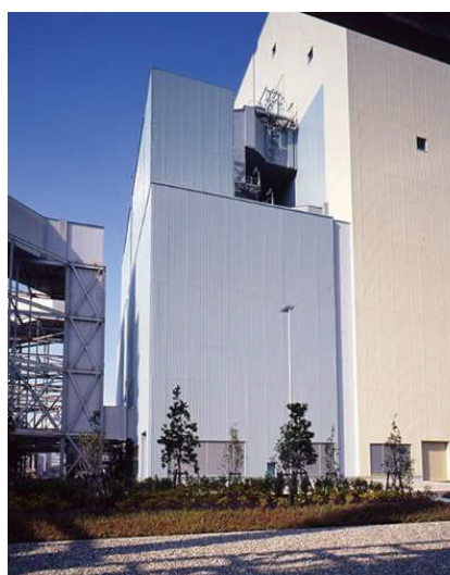
排煙脱硝装置(橘湾発電所)
