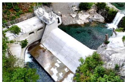
〈取水えん堤 全景〉
