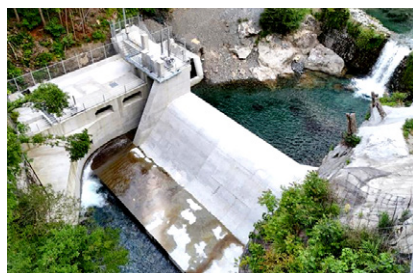
〈取水えん堤 全景〉
