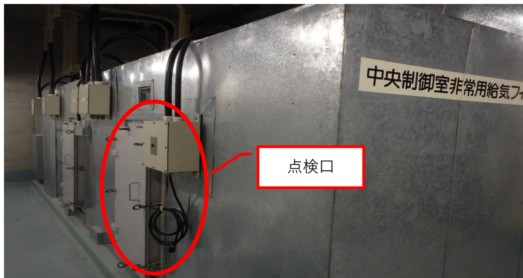
中央制御室非常用給気フィルタユニット3号
