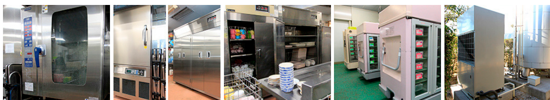
▲スチームコンベクションオープン ▲プラストチラー ▲保冷保管庫 ▲食器洗浄機 ▲食器保管庫 ▲業務用エコキュート
