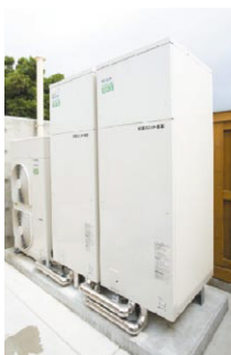
▲ヒートポンプ式給湯器
